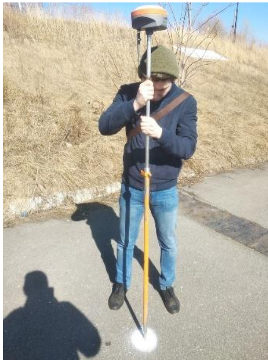
Рисунок 5.1 – Определение координат опознавательных знаков на местности
