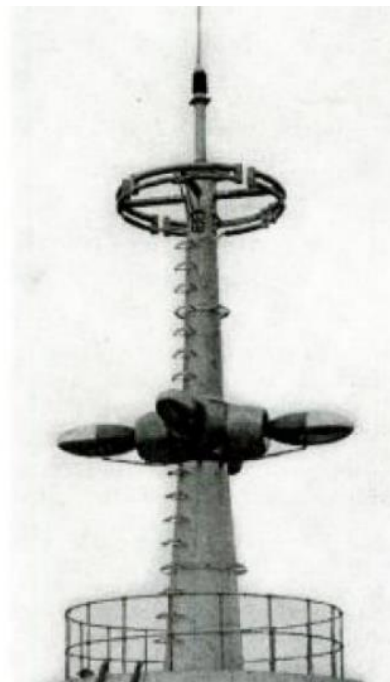
Рисунок 1.14 – Решетка антенн Линденблада на шпилье Эмпайр-стейт-билдинг
